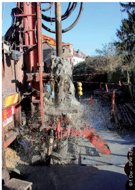
← Figure 7 : Forage Anderlecht (profondeur finale 120m)
